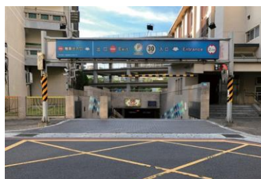
停車場出入口
