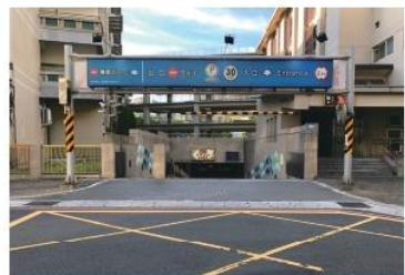
停車場出入口
