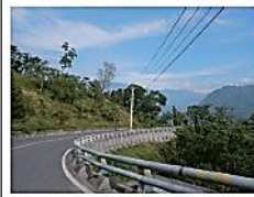
斜坡轉彎道路
