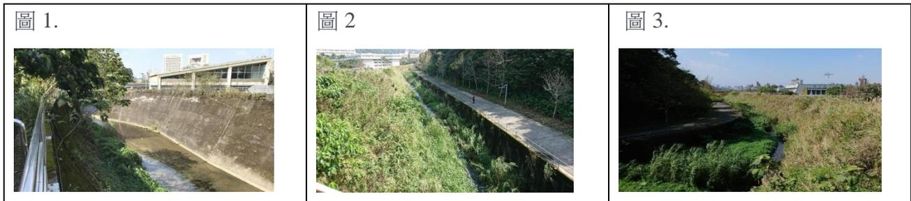
台灣河川營造過往的做法，是先使用混凝土堤岸確保防洪之單一目標後，再以表面綠美化的化妝手法，企圖改善生態與景觀。由於混凝土面層不具有生態發展所需的粗糙度及透水性，在此基礎上的綠美化並無法真正符合民眾對多樣生態系與豐富自然景觀的期待。本計畫之首要目標，即示範「防洪、生態、景觀：畢其功於一役」的設計手法，其主要策略如下。
