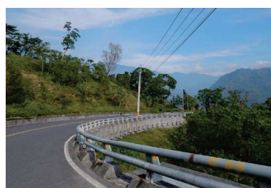
斜坡轉彎道路
